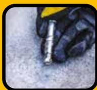
para proporcionar agarre, imparten esfuerzos de dilatación al soporte base. Para conseguir una fijación segura hay que tener siempre cuidado cuando se trabaja en las distancias del borde y tolerancias de separación.
