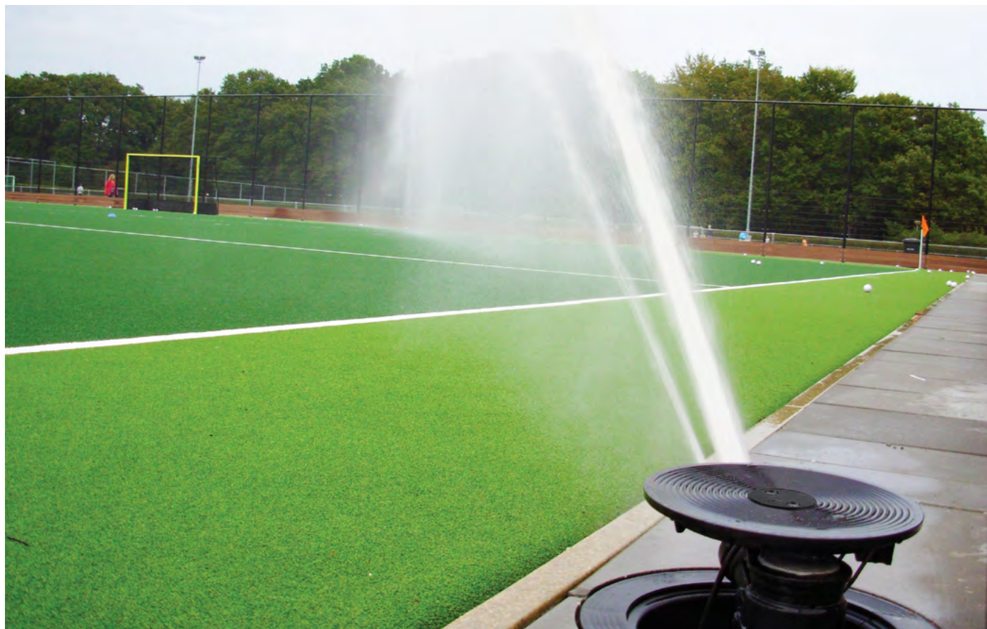
Cañón PERROT VP3 en funcionamiento.
