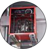
Detalle de aerotermo.
