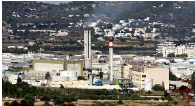
Central térmica GESA
