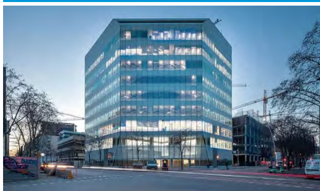
Hexagon Building 22@ Oficinas
