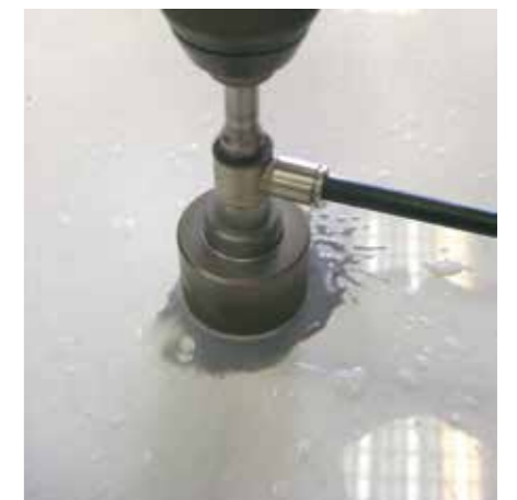
Perforación de gran diámetro / Big diameter drill.
