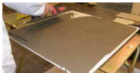
Aplicar con la parte plana de la llana, una fina capa de adhesivo en el reverso de la pieza / With the flat section of the trowel, apply a fine layer of adhesive on the back of the tile.
