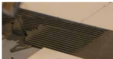
Extender y peinar el adhesivo con la llana sobre la superficie de colocación / Spread and comb the adhesive with the trowel over the installation surface.
