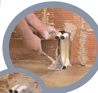
Colocar la curva doble completa en la roza de la pared. Puede ser de ladrillo o de pladur.
